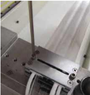
2. 用 M4 螺栓固定移动端接头
